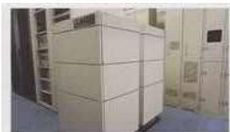
通信系の制御を行う指令システムの中核装置です。安全性を考慮し、現用・予備の二重化構造を採用しています。
