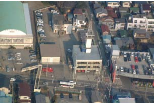
建て替え工事前の消防本庁舎（平成13年3月）
