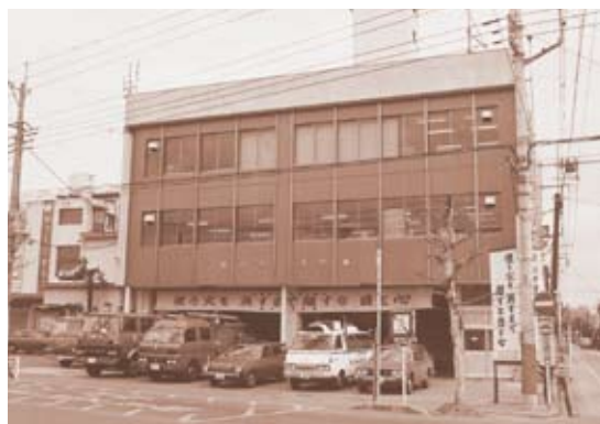
改修後の消防本庁舎
