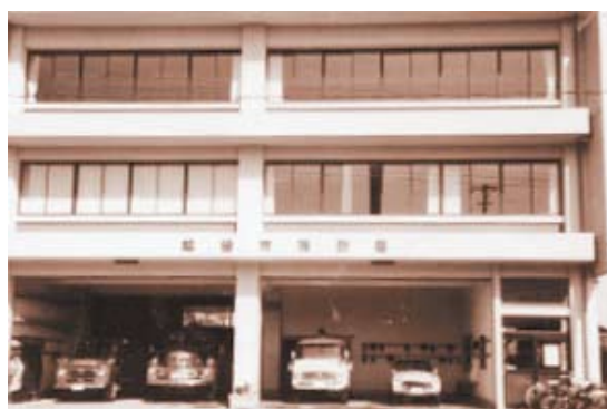
改修前の消防本庁舎
