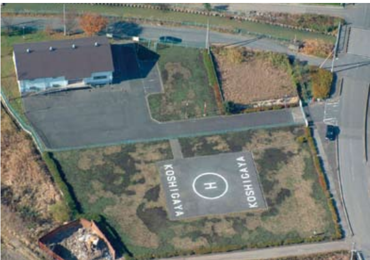
ヘリコプター離発着及び備蓄倉庫を備えた埼玉県越谷防災基地（越谷市北後谷4）
