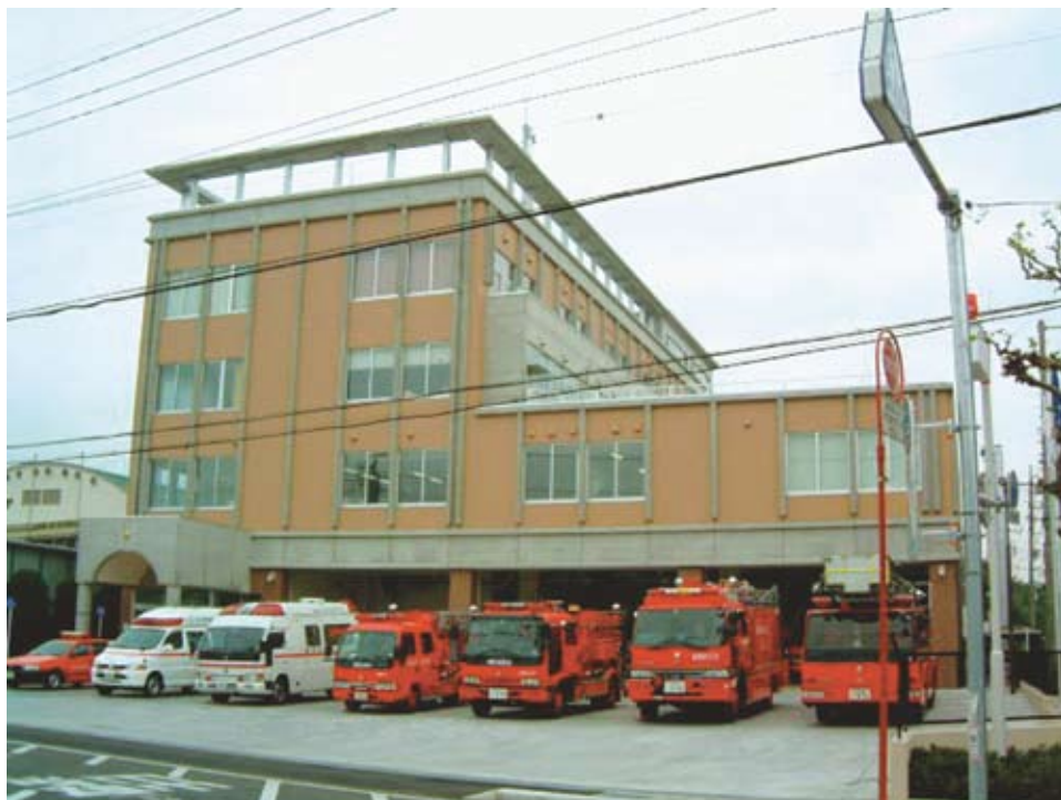
消防力強化のため消防本庁舎を新築（平成15年3月）
