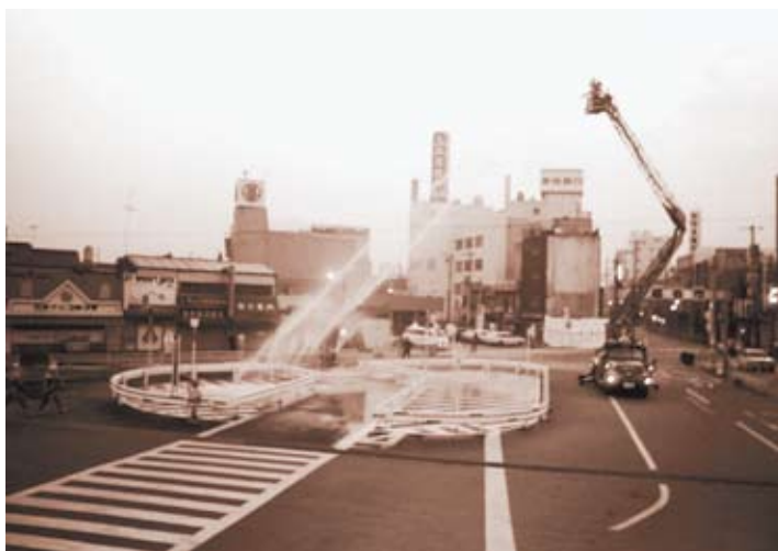
はしご車からの放水訓練（越谷駅前）
