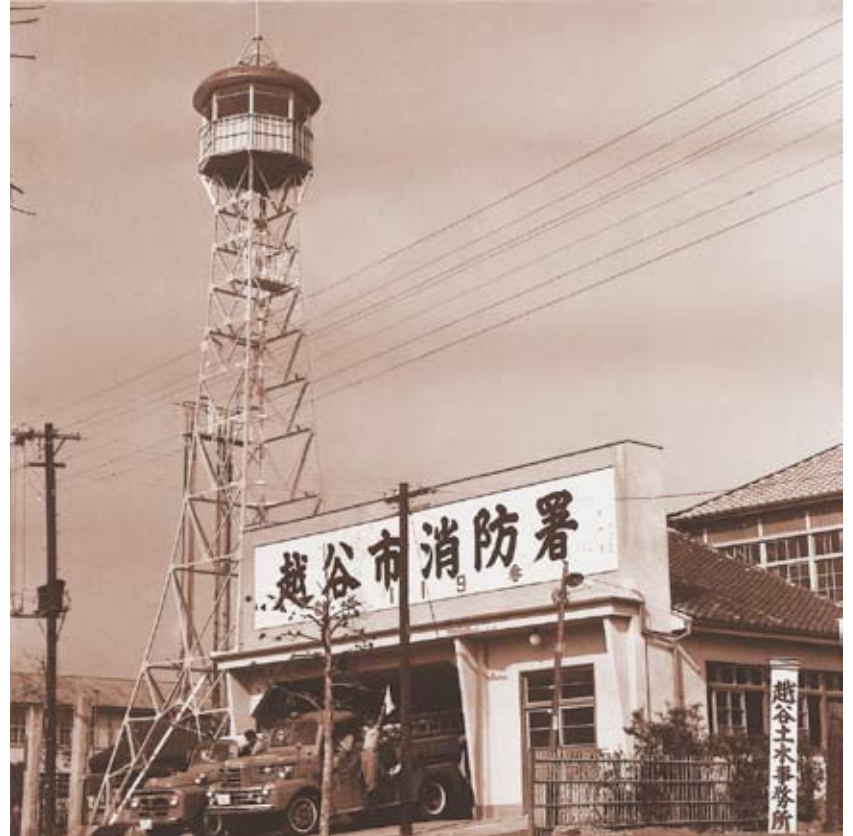
木造平屋建ての初代消防庁舎
