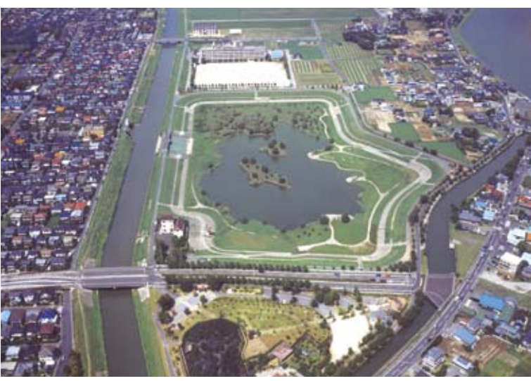
新方川左岸に造られた大吉調節池
