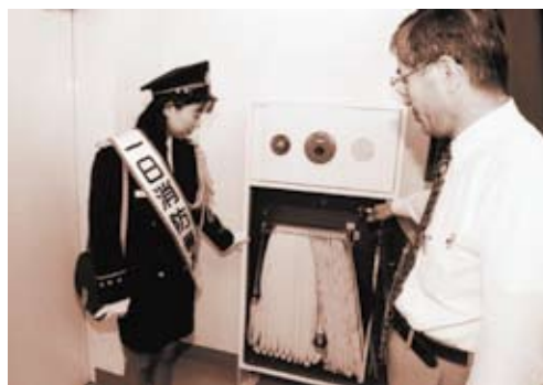
一日消防署長による消防設備の点検
