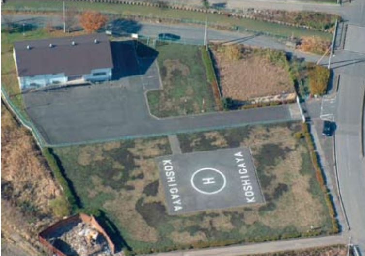
ヘリコプター離発着及び備蓄倉庫を備えた埼玉県越谷防災基地（越谷市北後谷4）
