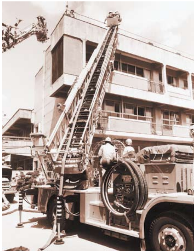
越谷市防災訓練（東越谷小学校 昭和57年9月11日）
