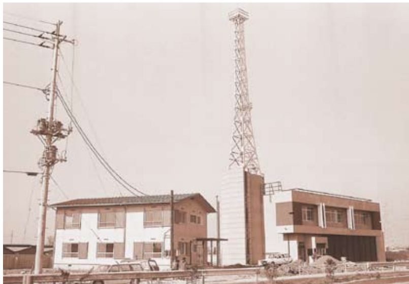
国道4号線沿いに完成した谷中分署（テレビ監視タワー付庁舎）
