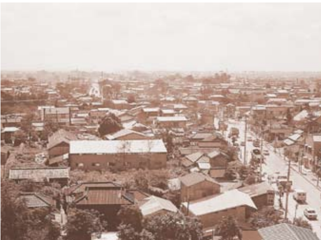
本庁舎南側の風景 (昭和42年)
