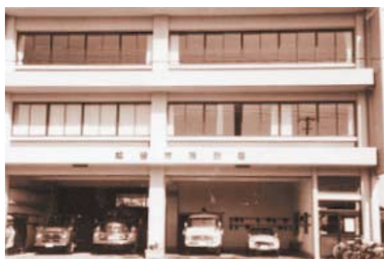
改修前の消防本庁舎
