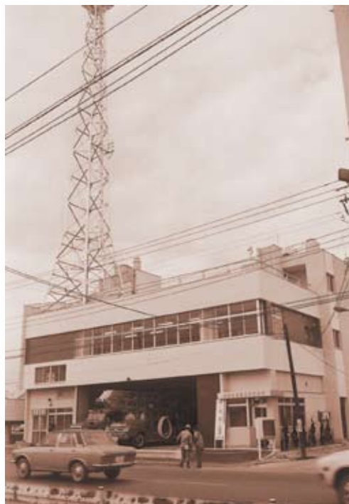
県道足立越谷線沿いに完成した蒲生分署
