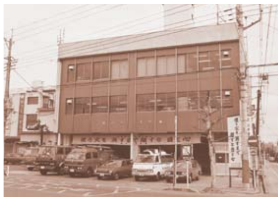
改修後の消防本庁舎
