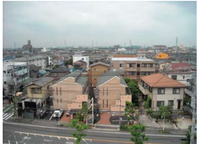
本庁舎西側の風景 (平成21年)
