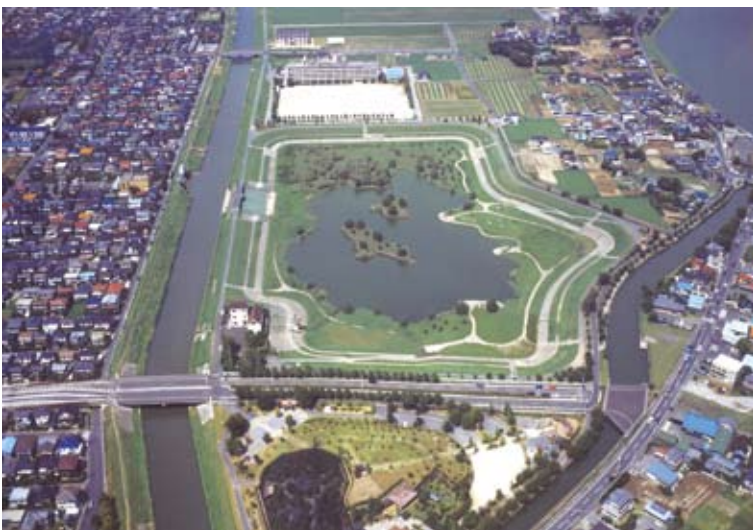
新方川左岸に造られた大吉調節池
