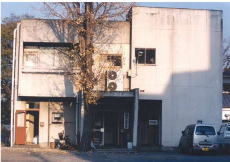
旧消防署庁舎東側にあった消防本部庁舎
