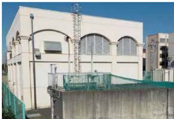
東越谷雨水ポンプ場
