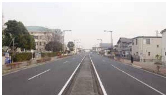
無電柱化が完了している大袋駅西口線
