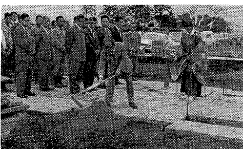
市営住宅、教職員住宅、養護老人ホーム、の起工式は8日行なわれました。市営、教職員住宅は来年2月、養護老人ホームは3月末に完成予定。(写真は市営住宅と教職員住宅の起工式)
