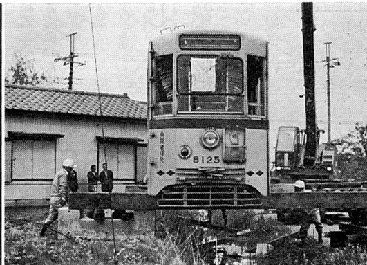
巨大な起重機で設置作業
