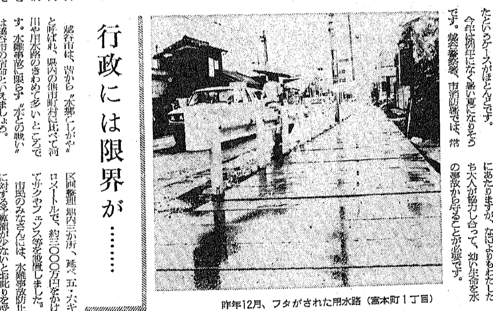
昨年12月、フタがされた排水路 (富本町1丁目)
