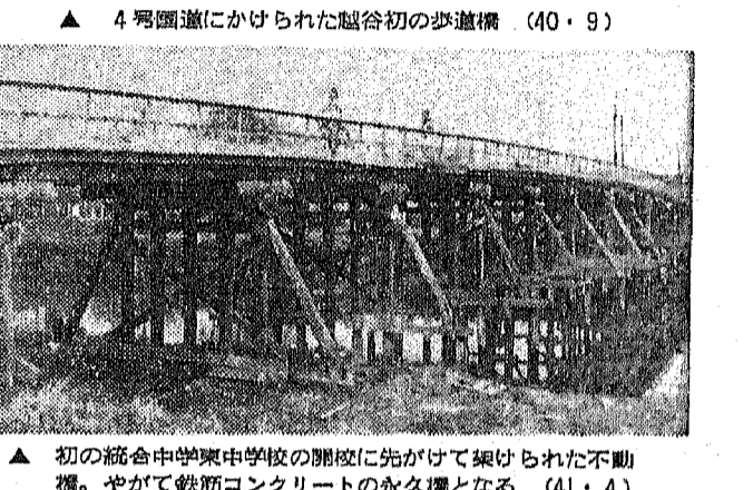
▲ 初の総合中学東中学校の開校に先がけて架けられた不動橋。やがて鉄筋コンクリートの永久橋となる (41・4)
