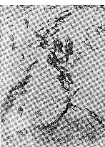
関東大地震による越谷市の被害 当時の人口………30,513人 当時の家屋………5,602棟 こわれた建物………1,666棟 死者………19人 けがをした人………66人
