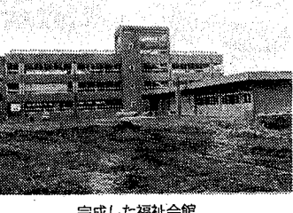
完成した福祉会館
