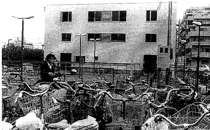
建設中の有料自転車駐車場
