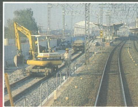
進む鉄道高架。平成9年度完成目指す
