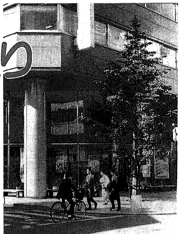
歩道と一体化したポケットパーク。ビル建設当初から市と協議して、1階部分を後退し空間を確保しました
