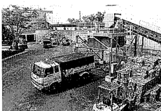
粗大ごみ処理センター
