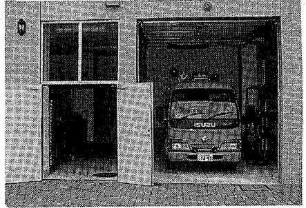
蒲生分団の消防ポンプ車庫
