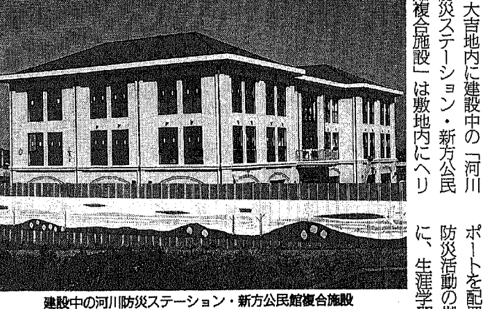
建設中の河川防災ステーション・新方公民館複合施設
