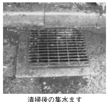
清掃後の集水ます
