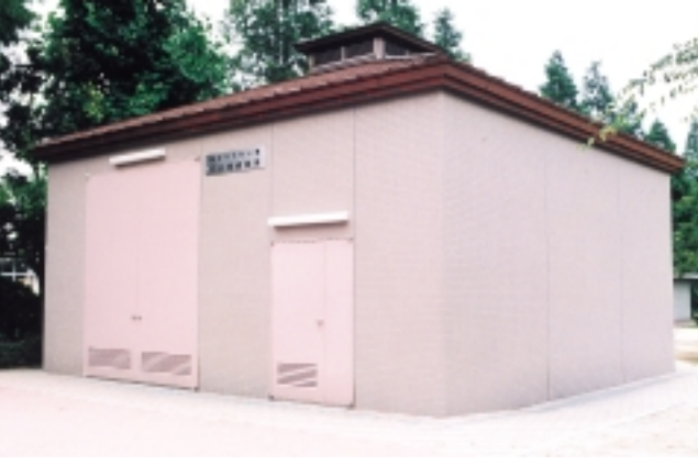
大杉公園の防災備蓄倉庫
