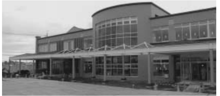
建設中の増林地区センター・公民館、教育センター
