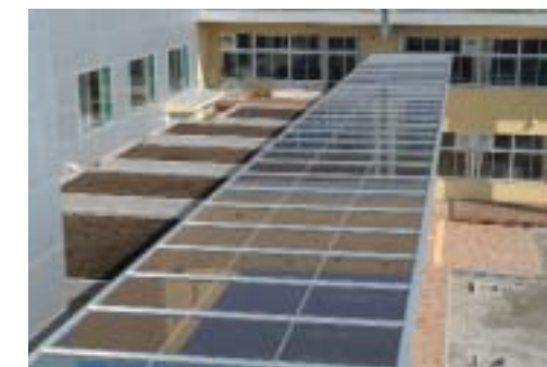
環境に配慮して、夜間電力や雨水の有効活用、太陽光を利用した発電設備を備えました。
