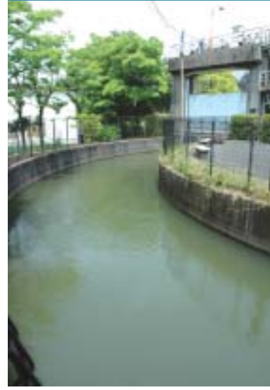
葛西用水(逆川)が新方川の下をくぐる伏せ越し
