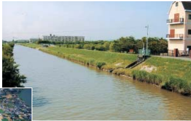
奥から河川防災ステーションを備えた新方地区センター、新栄中学校、さらに下流に進めば東側に大吉調節池が見えてきます
