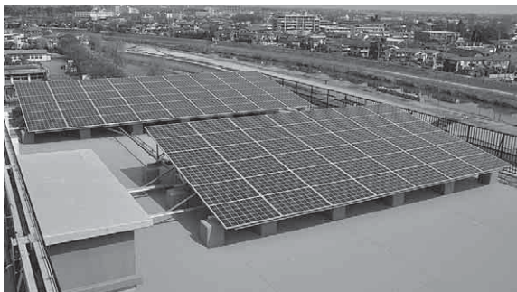
市の庁舎屋上に設置された太陽光発電設備
