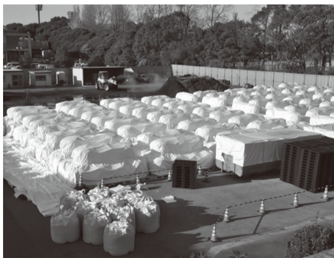
堆肥化施設に まで拡張した飛 灰の仮置き場
