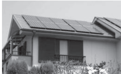
補助金を利用して設置された住宅用太陽光発電パネル
