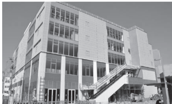
整備が進むB街区商業棟。4階・5階に市民活動支援センターが入ります
