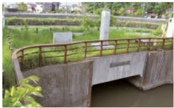
葛西用水の伏越。元荒川が左右に流れているのが見えます。葛西用水は左手奥の取水口から元荒川をくぐり、ここから出ていきます
