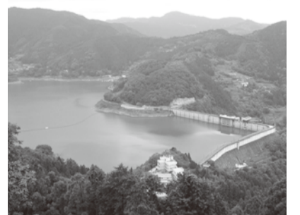
埼玉県と群馬県の境にある、下久保ダム
