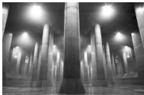
首都圏外郭放水路の調圧水槽(幅78m、長さ177m、高さ18m)。地下トンネルから流れてきた水の勢いを弱め、スムーズに流す巨大プールの役割をしています 出典：江戸川河川事務所
