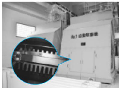
ポンプ場に入水する水の中には木の枝などゴミが含まれています。大きなゴミは自動除塵機(じょじんき)によって取り除きます。吹き出しの写真は除塵機の内蔵。回転しゴミを取り除きます
