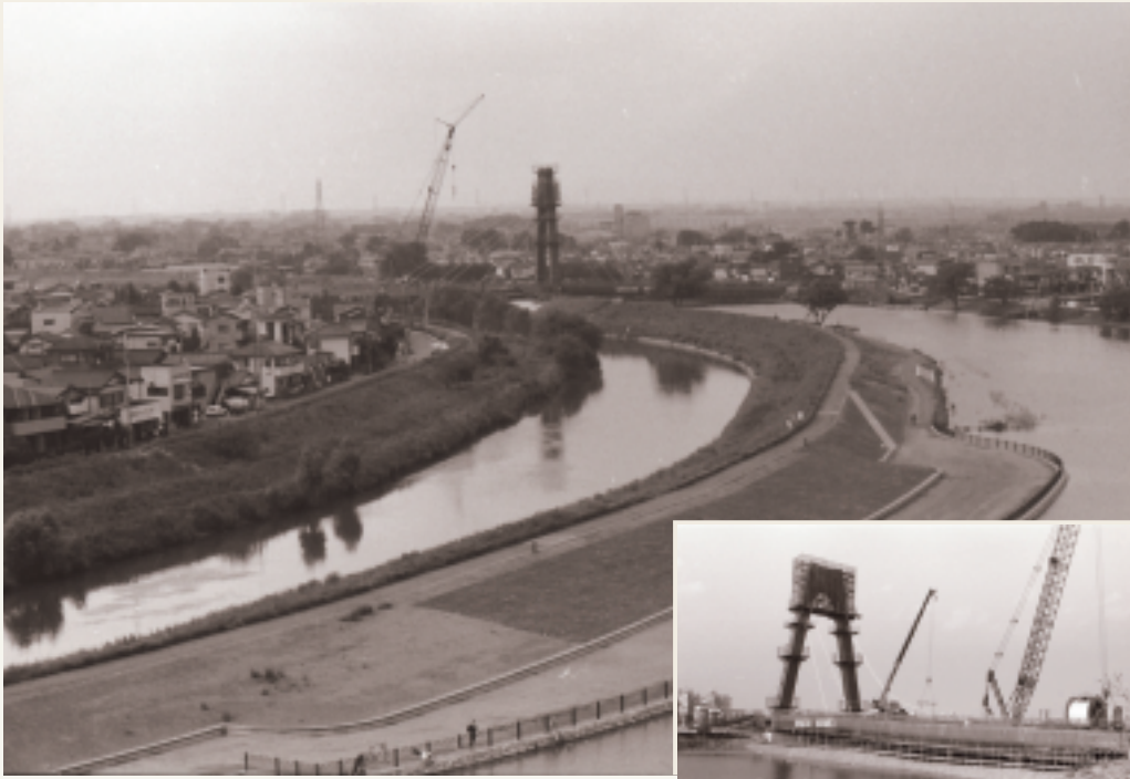
▲建設途中のしらこぼと橋（平成5年5月撮影）
