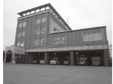
平成15年に建てられた消防本庁舎 (4階建て)
