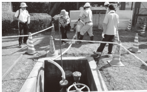
地下に設置された貯水槽から手動ポンプなどで水を汲み上げます
