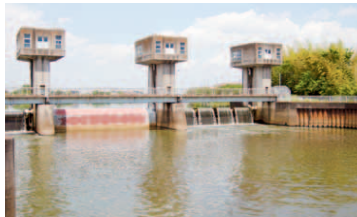
越谷市と松伏町との境を流れる大落古利根川にある古利根堰。江戸時代から続く堰で、葛西用水の取水に利用されます。
