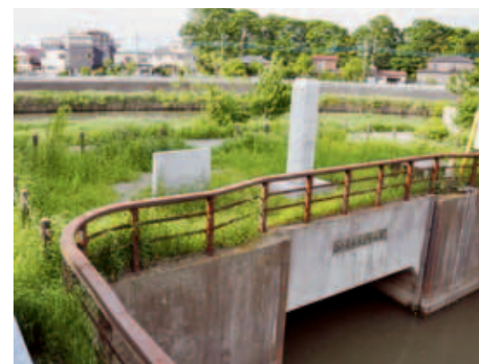
元荒川の下を葛西用水が通るとい珍しい川の立体交差で「伏越」と呼ばれます。
