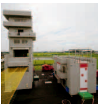
消火訓練や救助訓練を行う訓練棟
