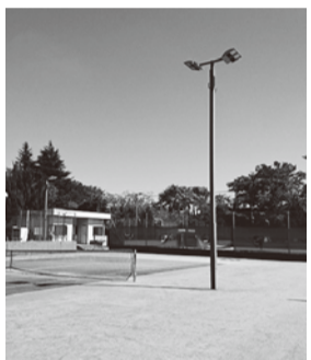
改修した夜間照明
