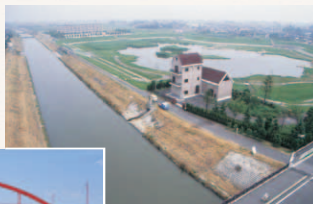
▲大吉調節池が完成(平成3年)
