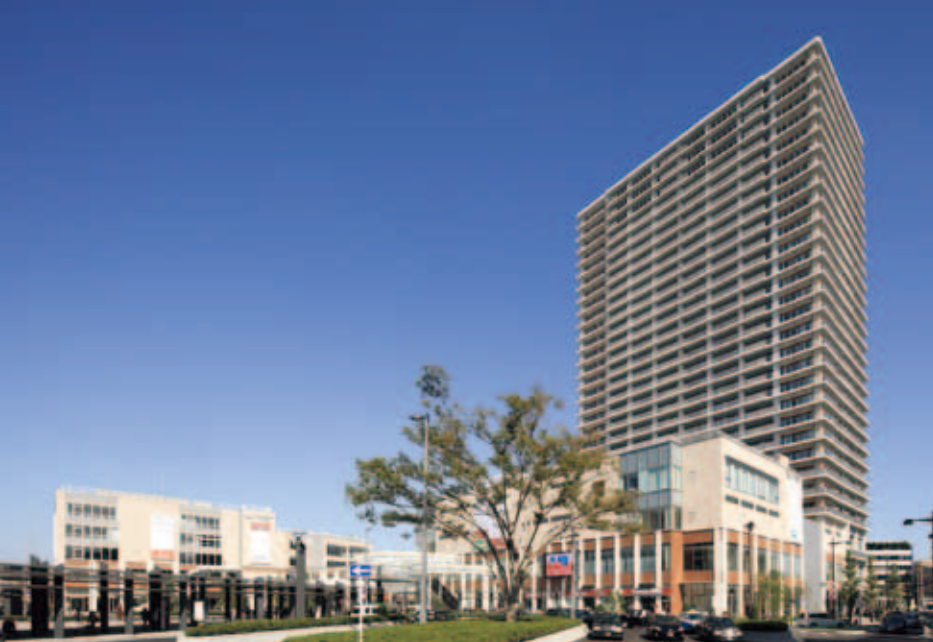
▲越谷ツインシティがオープン(平成24年)
