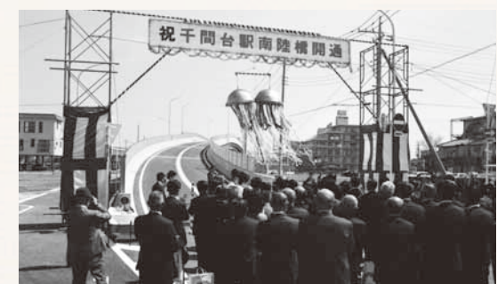
▲千間台駅南陸橋が開通(昭和57年)
