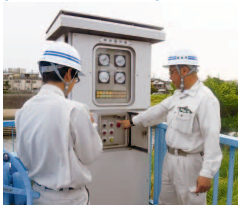
▲市の職員が毎月行っている水防パトロールの様子。ポンプなどの施設の状況を日頃からチェックし、大雨の際に正常に稼働するよう努めています
