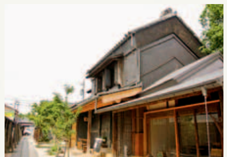
土蔵外観。敷地奥から旧日光街道方面に撮影
