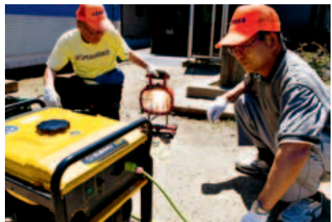
自治会の備品の発電機を点検中
