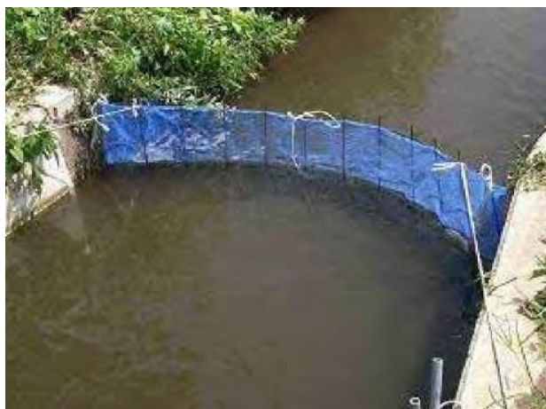
流出防止を目的とした網の設置例
