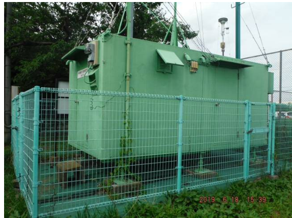
○コンテナ（近景）
