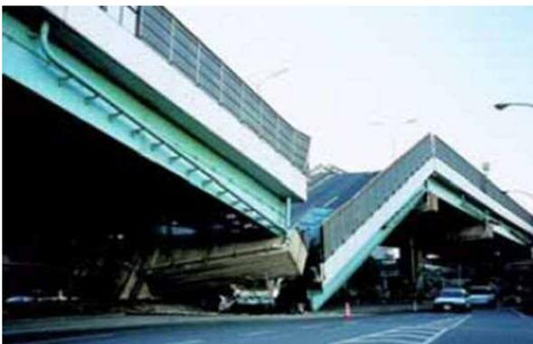
図-1 下部構造が倒壊した例
