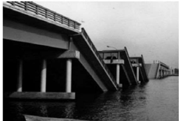
図-2 下部構造が大変位した例
