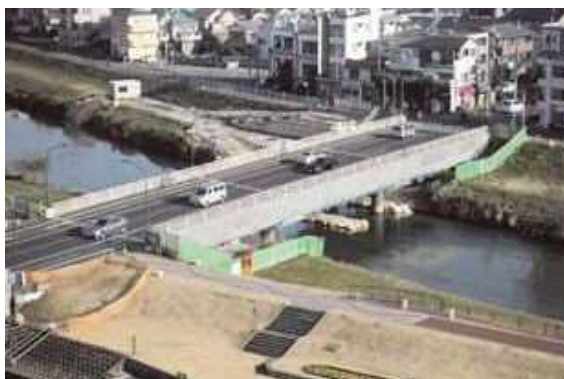
災害に備えて橋長15メートル以上の重要な橋りょうの耐震化を計画的に進めています (新平和橋橋梁耐震整備工事)
