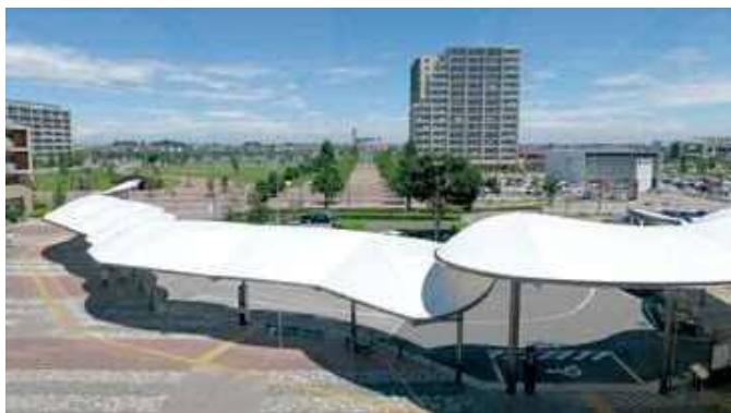
都市景観や防災上の観点から電線類を地中化し、整備された街並み (越谷レイクタウン駅周辺)
