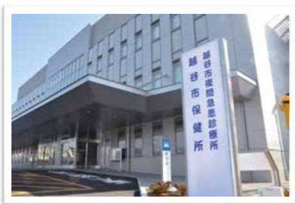
越谷市保健所
