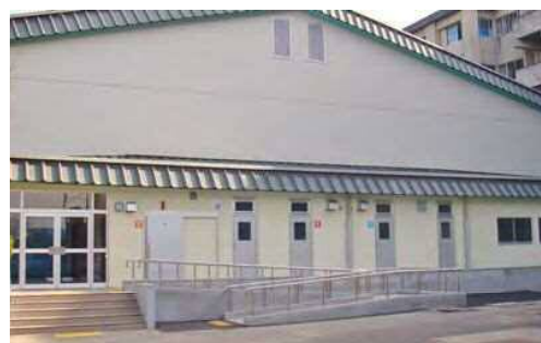
屋内運動場の改修
