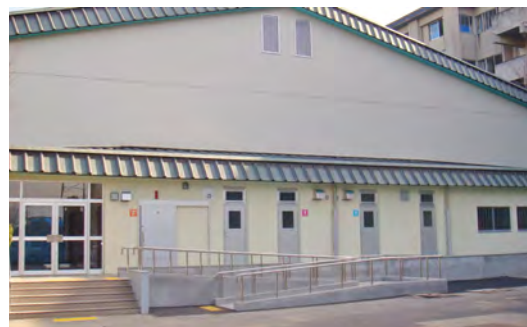
屋内運動場の改修
