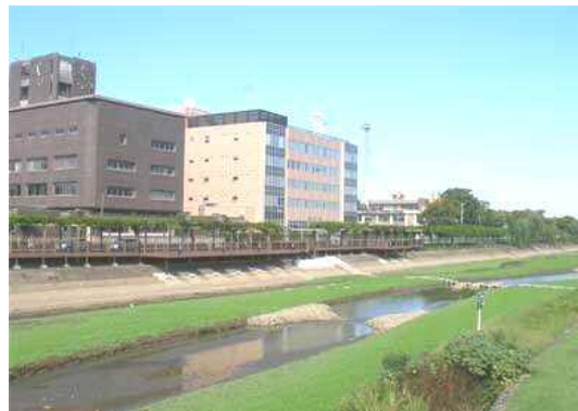
■葛西用水ウッドデッキ／越谷市
