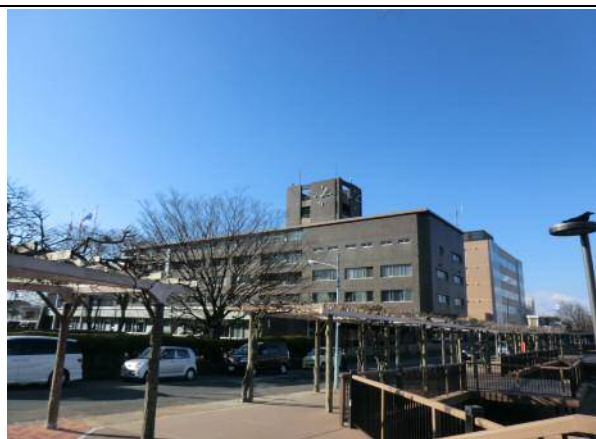
葛西用水ウッドデッキ
