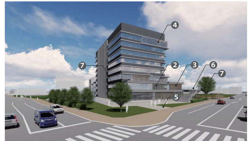
▲C 越谷駅前線より（南西側より）
