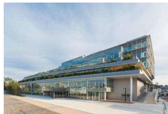
大和市文化創造拠点シリウス (芸術文化ホール、図書館、生涯学習センター、屋内こども広場を有する複合施設)
