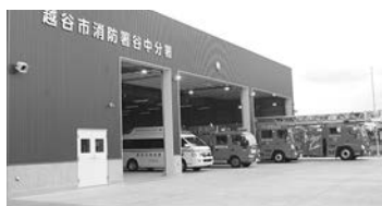
9月1日に供用を開始した消防署谷中分署
