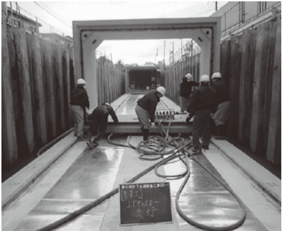
幹線排水路の整備
