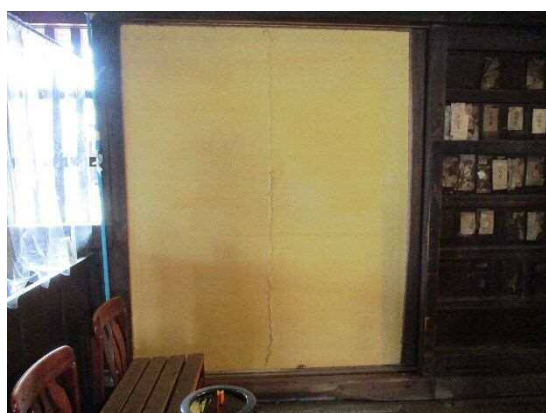
【施工前】主屋壁修繕(大戸口脇土壁)
