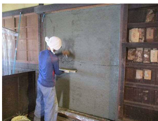
【施行中】荒壁施工の様子
