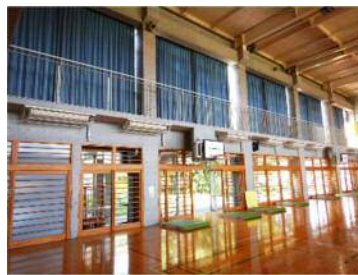
屋内運動場への空調設備設置
